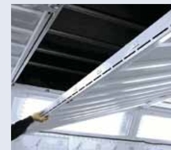
Filtri cielo con possibilità di apertura per una facile sostituzione. Easy opening and ceiling filters replacement.
